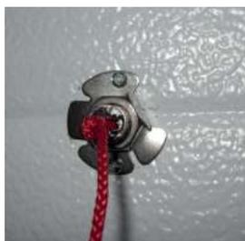
Ouvrir la porte et attacher la cordelette à la manette de déverrouillage du moteur
